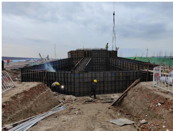
图 3-12 江苏东台风电场 200MW 风电特许权项目现场照片
