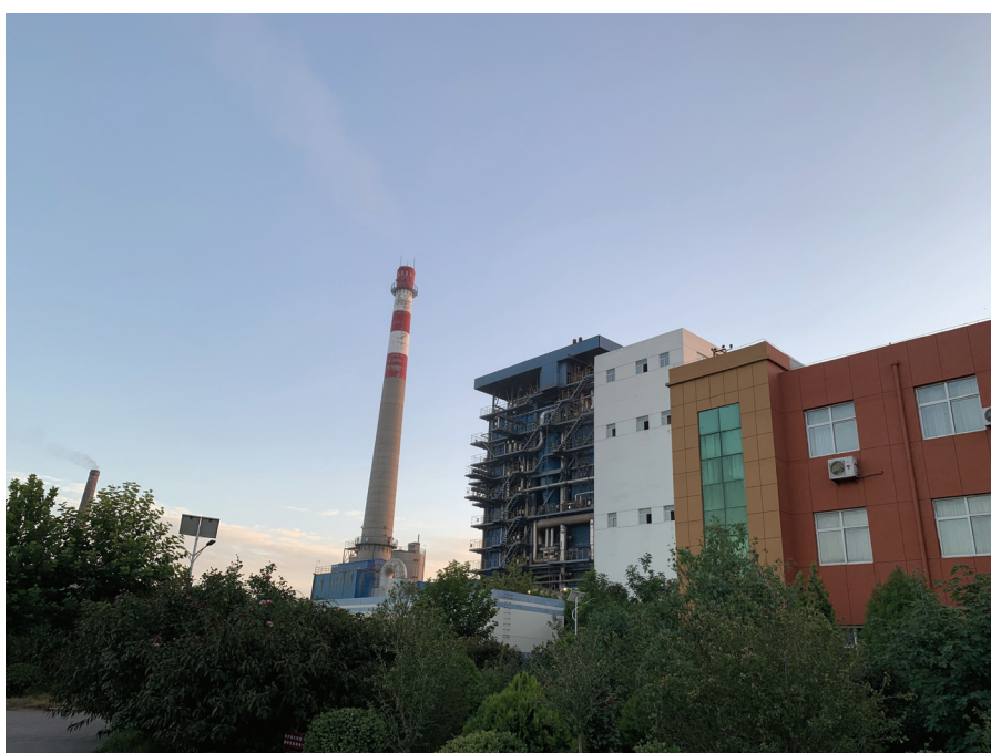
图 3.2 锅炉房、烟囱、综合办公楼
