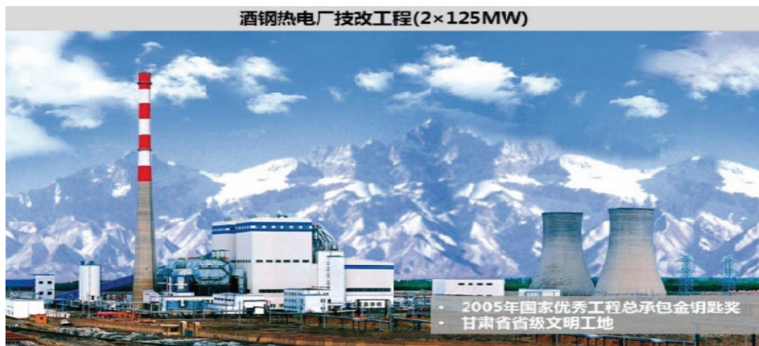
图2 获国家优秀工程总承包金钥匙奖的酒钢热电厂技改工程
