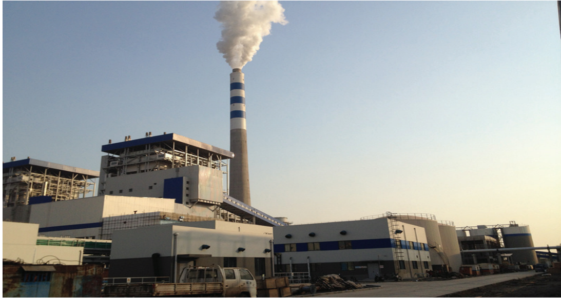
图 2 山东日照岚山区集中供热工程外貌
