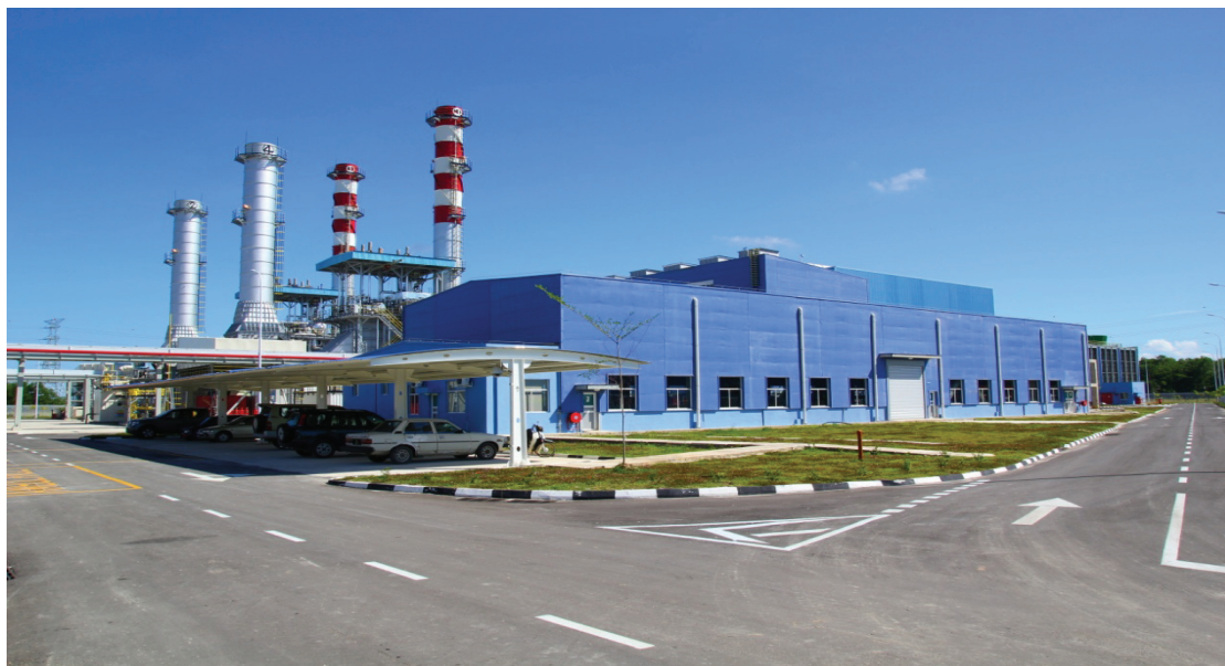
图 3 马来西亚沙巴 SPR100MW 燃机联合循环发电项目外貌
