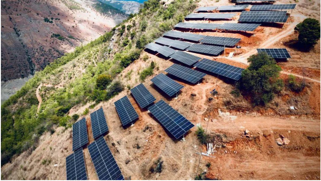
图 5.3-2 列瓦镇光伏提水灌溉项目现场照片
