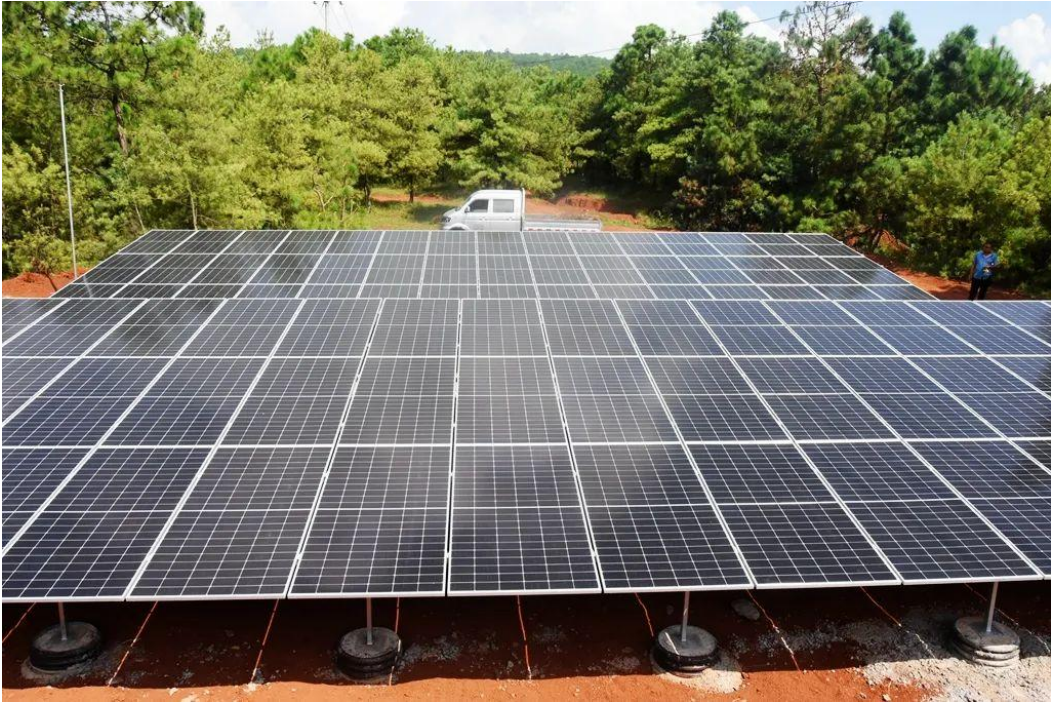
图 5.3-3 列瓦镇光伏提水灌溉项目现场照片
