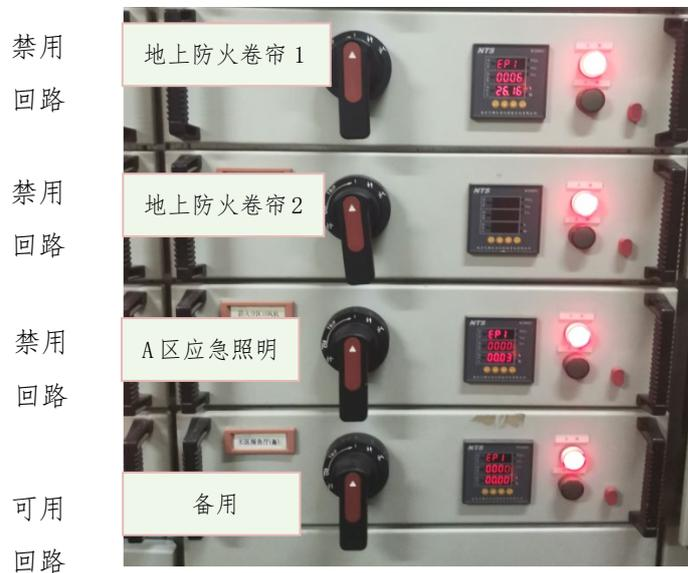
图 5 充电负荷接入示意图
