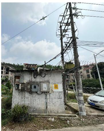
图1 独立建筑型式低压配电站
