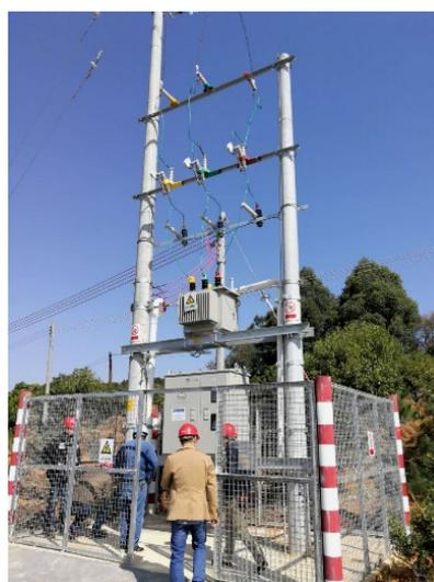
图4 南方电网公司台架布置图
