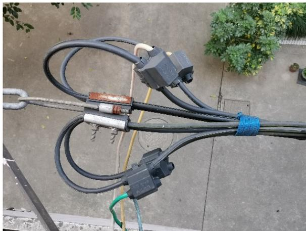
图 2 集束导线终端安装示意
